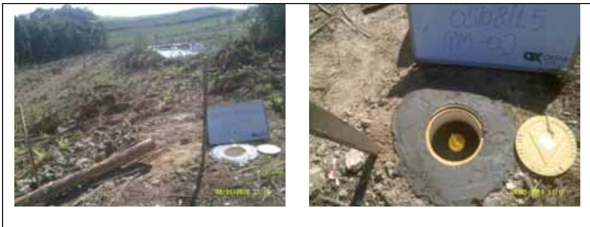
Figura 10. Poço de monitoramento instalado PM-02
