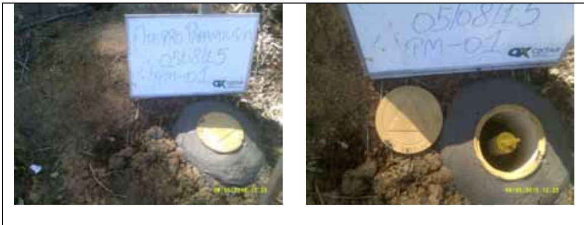
Figura 9. Poço de monitoramento instalado PM-01.
