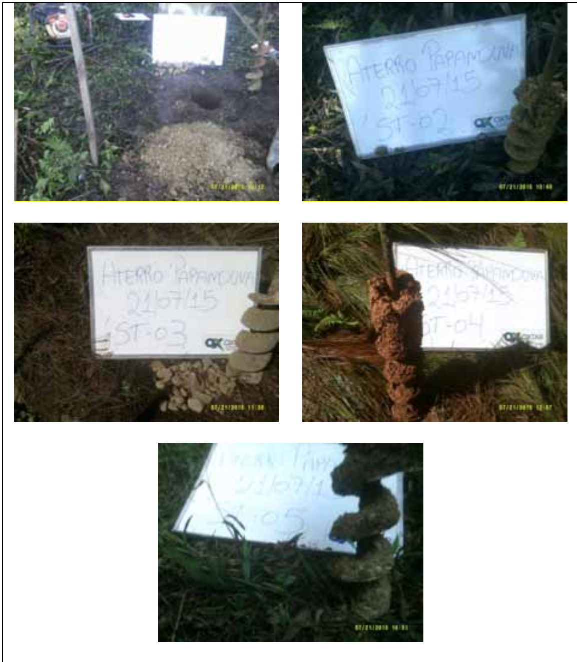
Figura 7. Imagens ilustrativas das sondagens realizadas pela Oxtar, com trado manual e motorizado.
