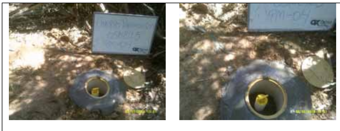
Figura 12. Poço de monitoramento instalado PM-04
