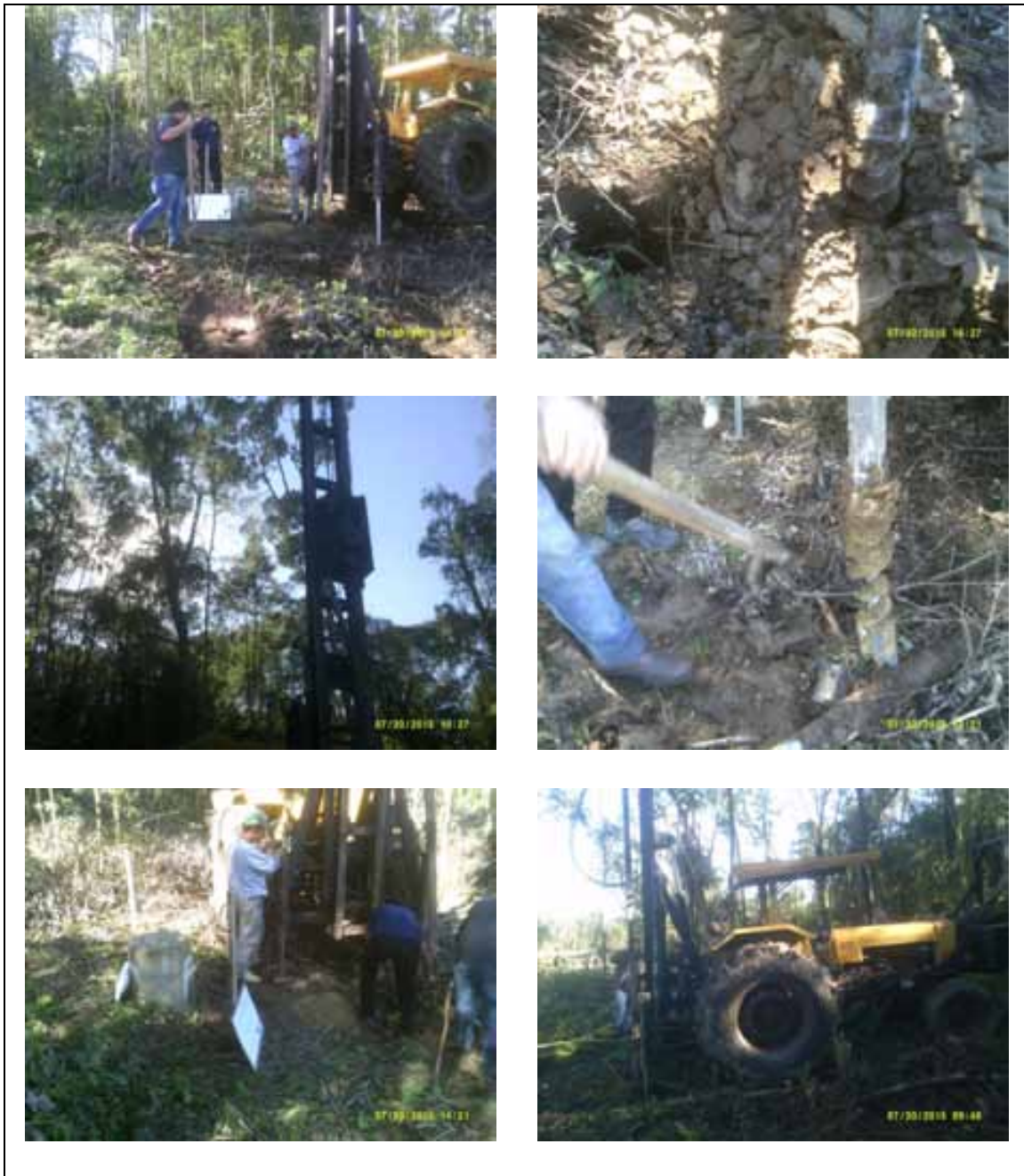
Figura 8. Imagens ilustrativas das sondagens realizadas pela empresa contratada pelo empreendimento, com perfurador hidráulico.
