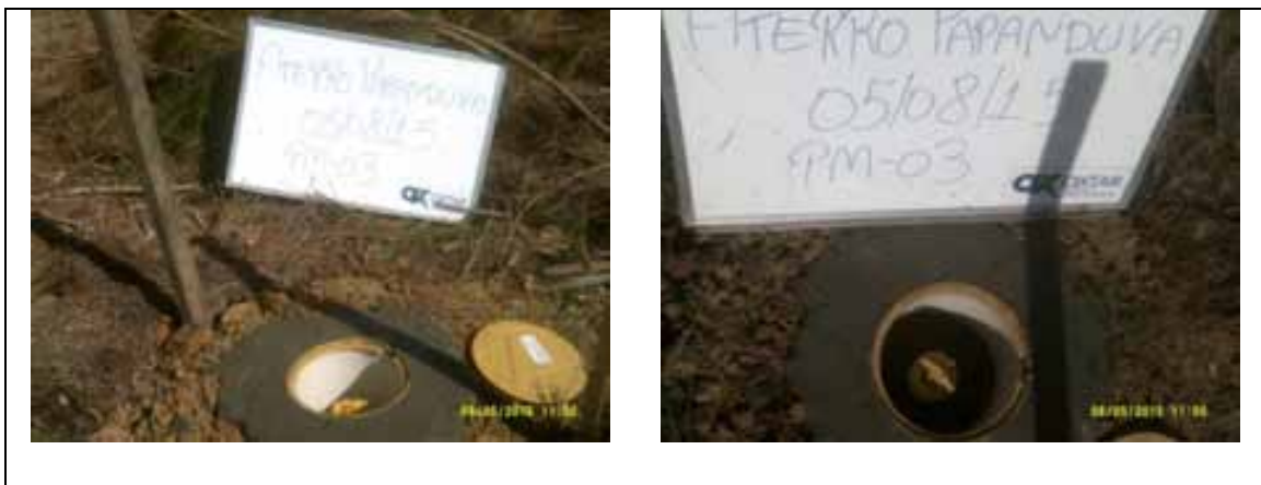
Figura 11. Poço de monitoramento instalado PM-03.
